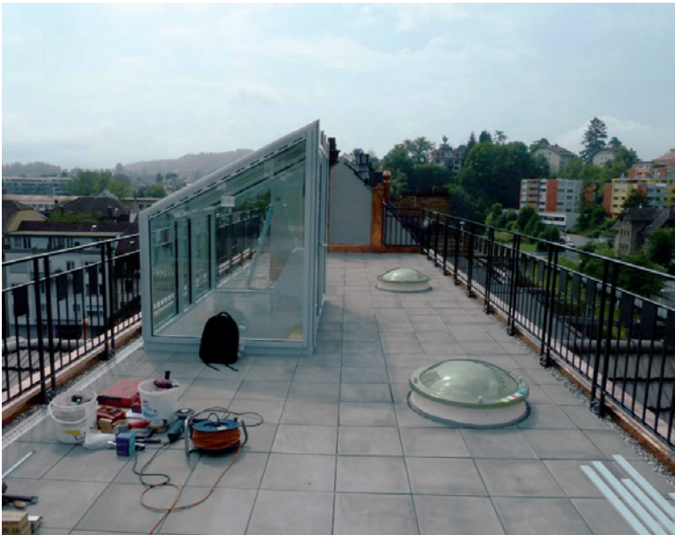
das neue Dach
