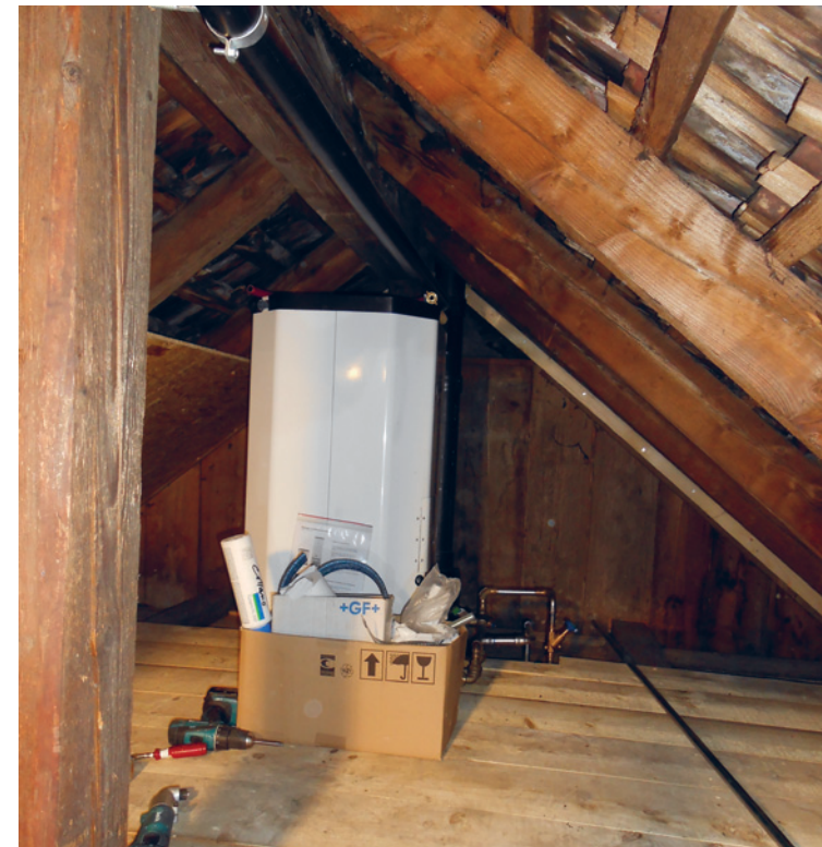
Der sanierte Dachstock
