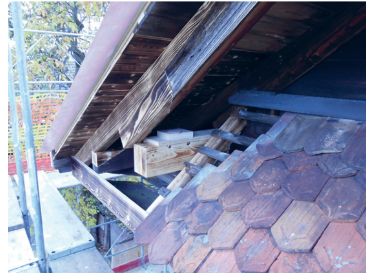
Einblick in die Dachkonstruktion
