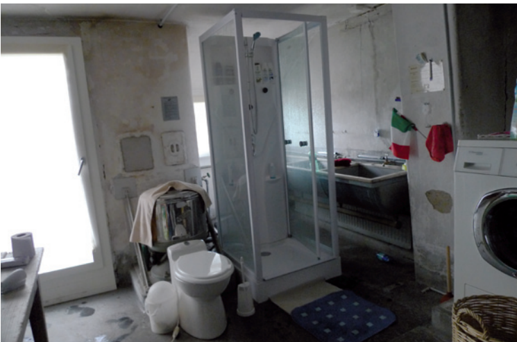
Provisorium Dusche/WC Dachgeschoss
