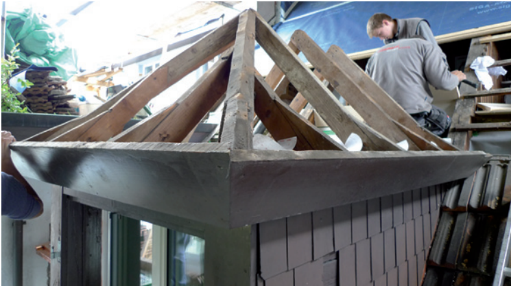
Arbeiten an Lukarne
