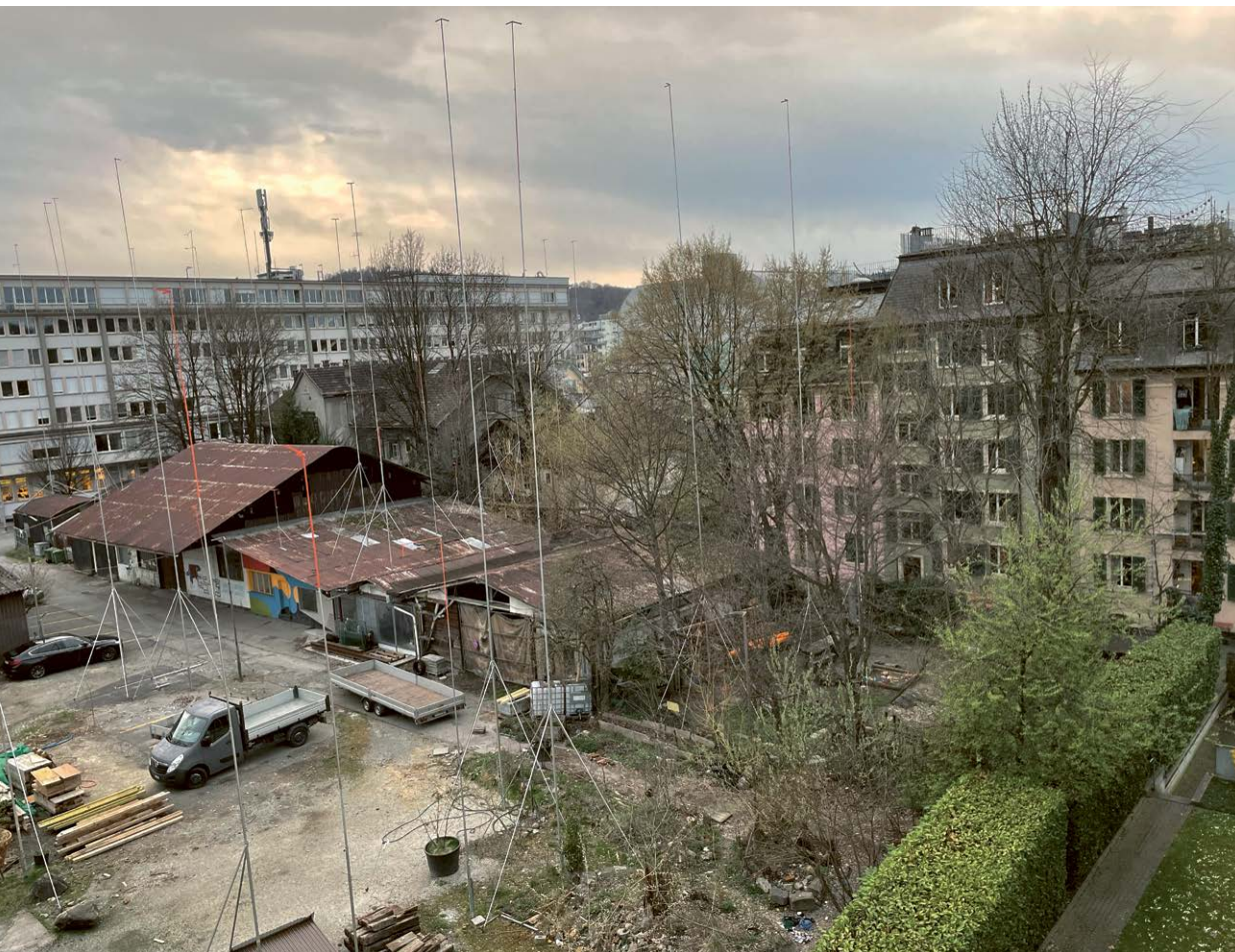
Baugespann für das Haus der WOGENO Luzern Foto: Lukas Berger
