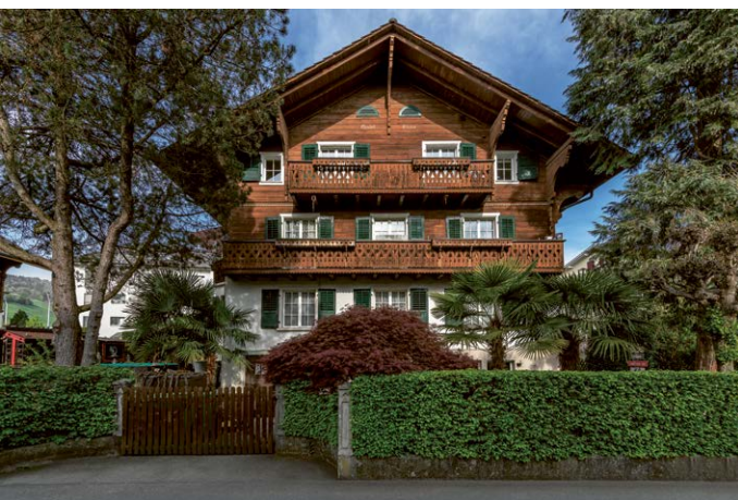
Strassenansicht Pilatusstrasse 28, Kriens
