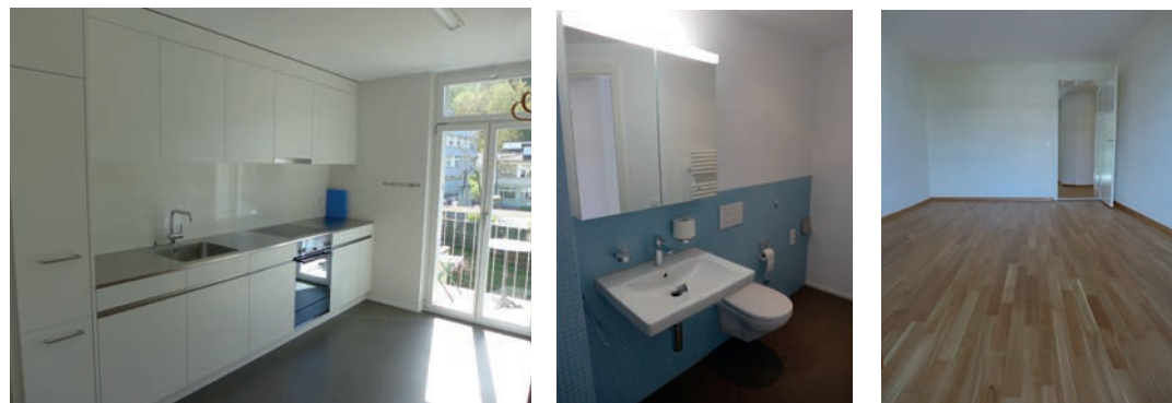
Vonmattstrasse 26 Sanierung von Küche, Bad und Zimmer nach dem Wohnungswechsel
