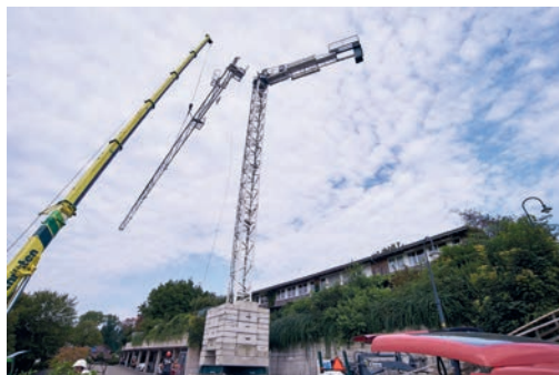
Kranmontage bei Schauburg 10
